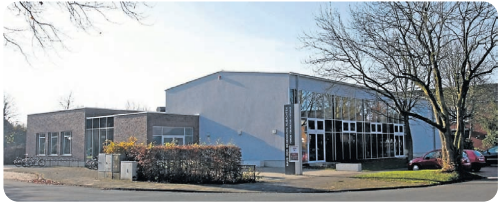
Ursprünglich als Forum für die zahlreichen kulturellen Veranstaltungen in Albachten konzipiert, hat sich das Haus der Begegnung mit der Adresse Hohe Geist 8 seit 2007, dem Jahr seiner Eröffnung, zu einem Veranstaltungszentrum mit überregionalem Einzugsbereich entwickelt.
